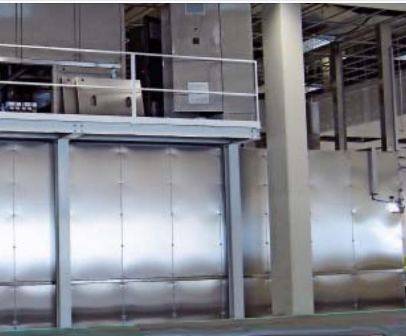
**Bild 3: Trocknungstunnel und oben platziertes Entfeuchtungsmodul Airgenex med während der Montage**
