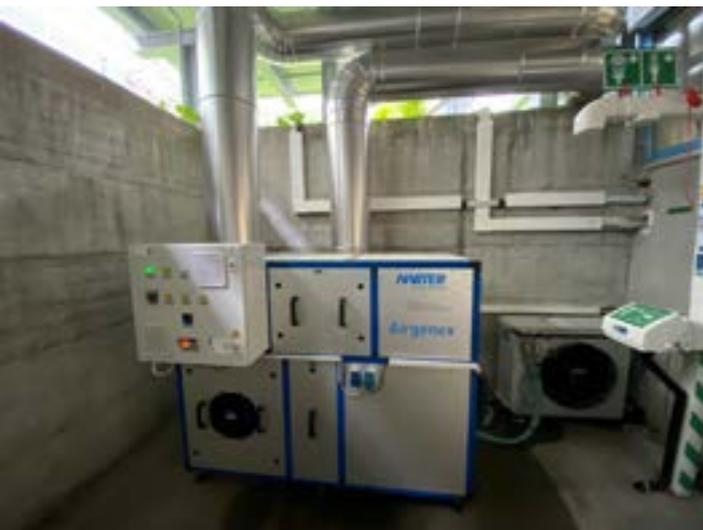
Das Entfeuchtungsmodul, das die Prozessluft aufbereitet, kann bei Platzmangel separat installiert werden. Durch eine isolierte Verrohrung ist es mit dem Trockner verbunden. (Bild: Harter)
