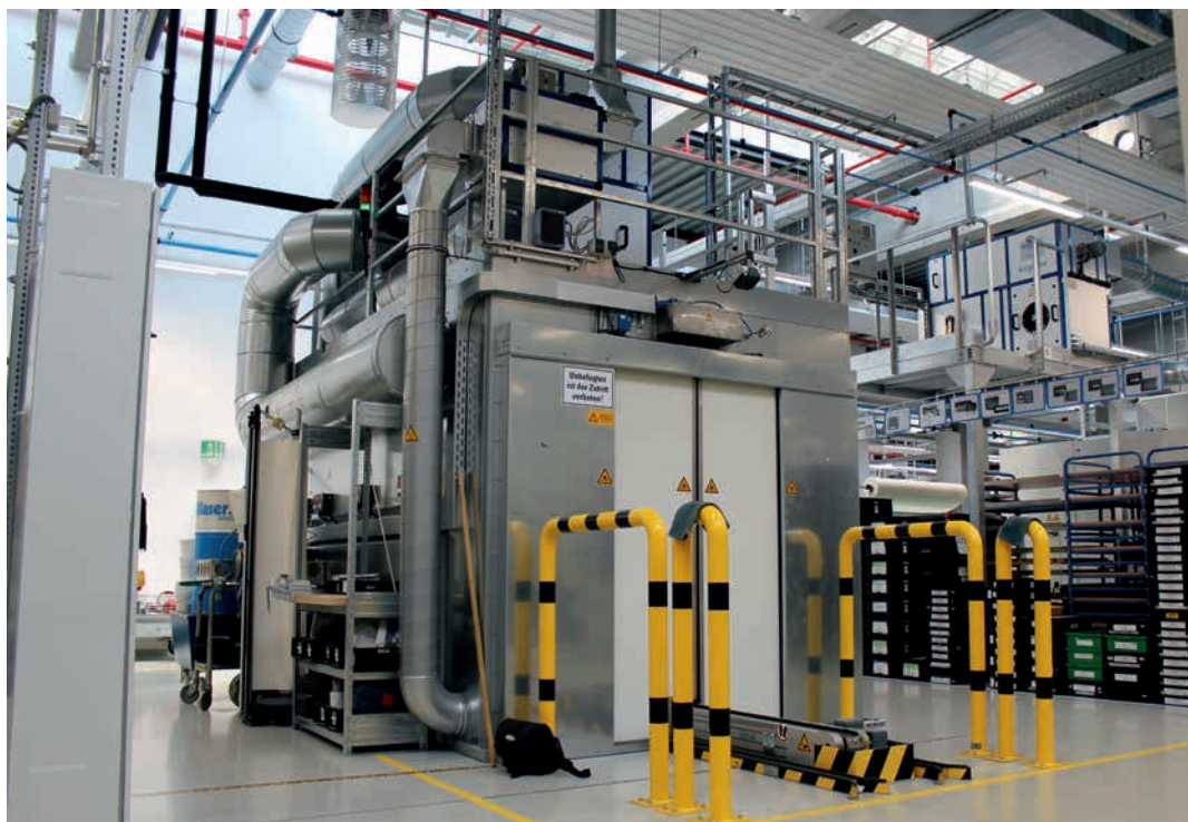
Abdunsten und Trocknen erfolgen in der „Airgenex“-Kombi-Anlage.
