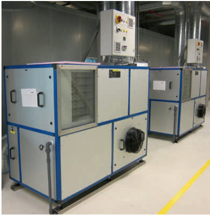
Zwei Wärmepumpenmodule bereiten die Prozessluft auf und sorgen somit für das richtige Klima im Trocknungsprozess. Extrem trockene Luft wird über das Trocknungsgut geführt und entzieht somit die Feuchtigkeit – bei niedrigen Temperaturen.
