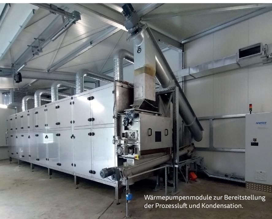
Wärmepumpenmodule zur Bereitstellung der Prozessluft und Kondensation.
